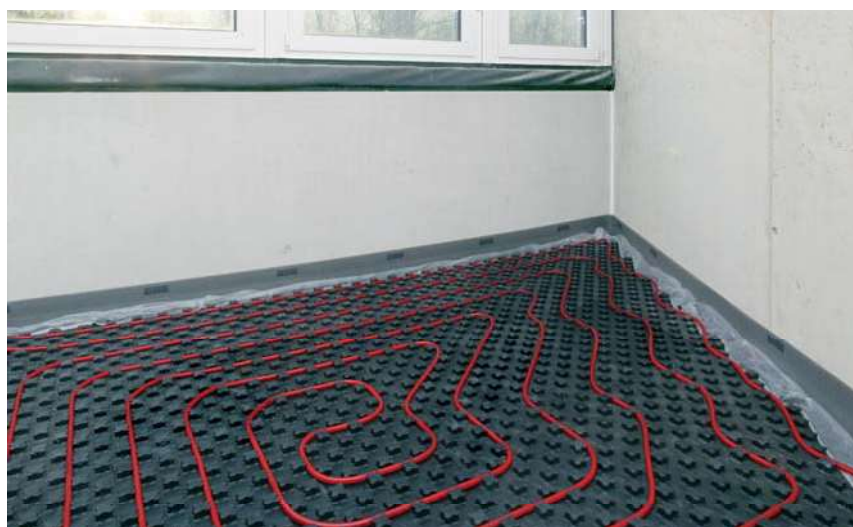
Rys. 2-11 Płyta systemowa Varionova REHAU ze spodnią izolacją akustyczną 30-2
